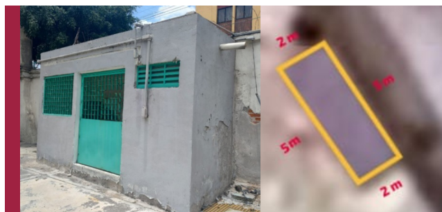
Figura 42. Caseta de cloración y esquema del perímetro de esta en el pozo Mar Mediterráneo.
