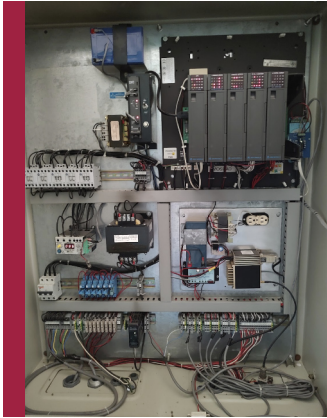
Figura 29. Sistema de telemetría en funcionamiento en pozo Deportivo Durango.
