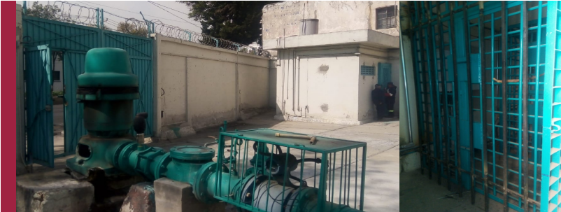
Figura 38. Caseta y seguridad del pozo Mar Mediterráneo.
